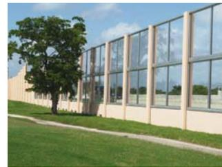
Assemblages cadre et panneau entièrement préfabriqués qui s'adaptent à tout système antibruit monté au sol
