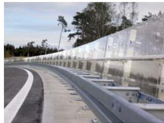
Caractéristique de rétention de fragments qui empêche les débris de tomber sous l'impact d'un véhicule
