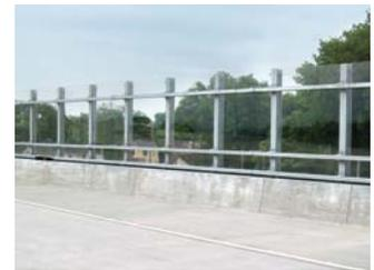
Système approuvé pour les ponts et les applications routières en hauteur et ayant réussi les essais de collision en vertu des normes du NCHRP 350
