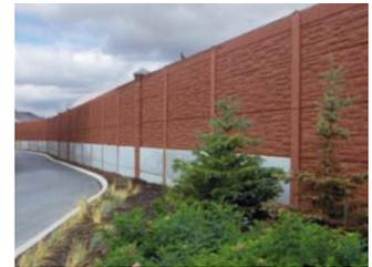
Système à écran antibruit et mur de soutènement combinés
